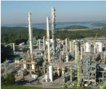
Perstorp ABs chemical production site in Stenungsund
